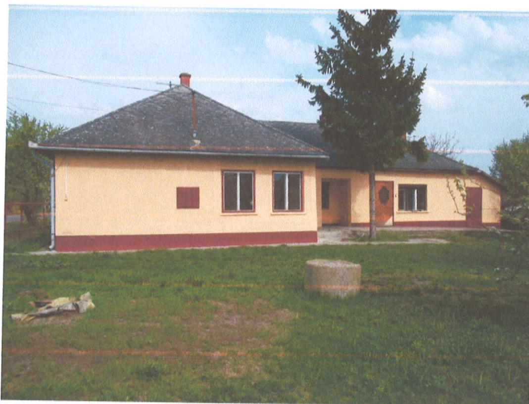
BONTANDÓ LAKÓÉPÜLET UDVAR FELŐLI KÉPE
