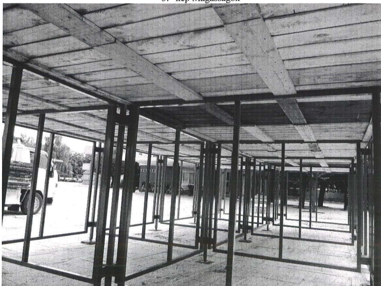
4. kép Pallók és haránt összekötésük alulnézetben
